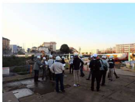
現場視察会(空堀川・東大和市)
