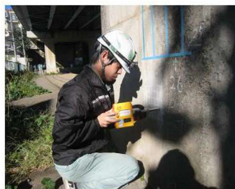
橋梁の点検状況
