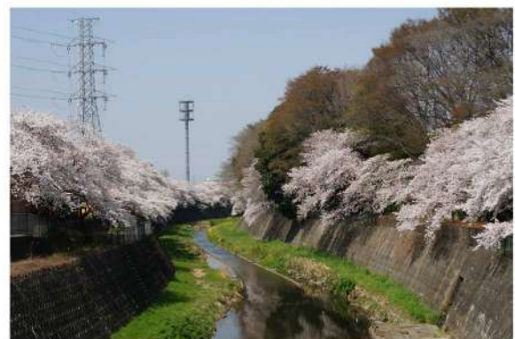
立川橋上流付近(立川市)
