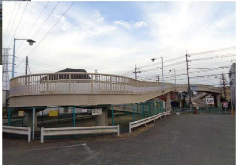
〔塗替え塗装: 補修後〕
