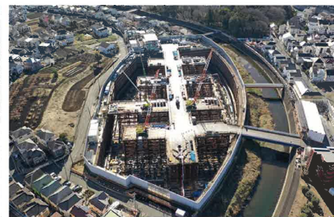
境川金森調節池の工事状況
