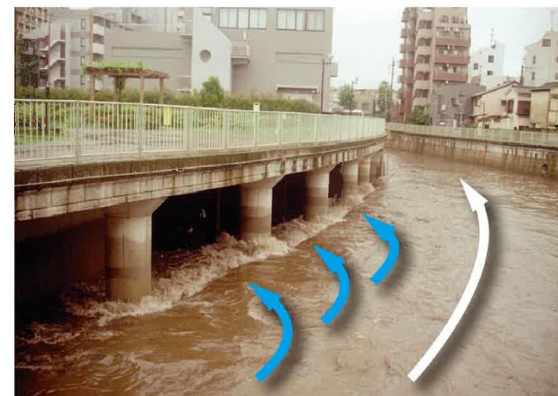
神田川取水施設への流入状況
