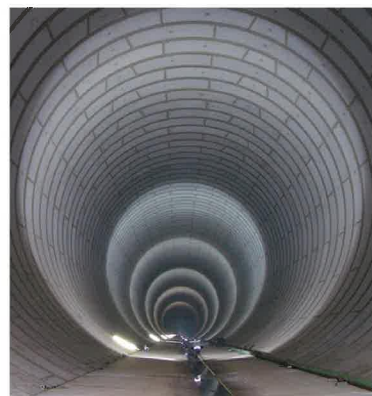
神田川・環状七号線地下調節池
