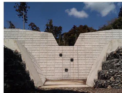
砂防堰堤(大島町差木地沢)
