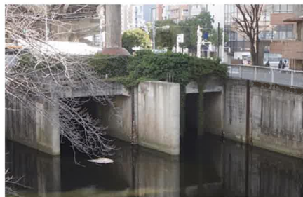
江戸川橋分水路
