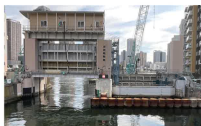
水門の耐震対策の様子(亀島川水門)
