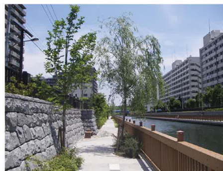
河川環境に配慮した河道整備(小名木川)
