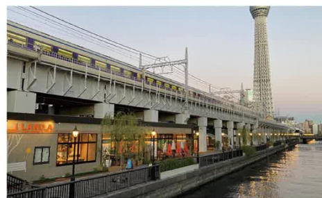
親水テラスと高架下店舗(北十間川 墨田区向島)
