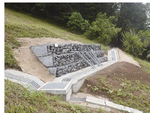
排水ボーリング工(あきる野市寺岡地区)
