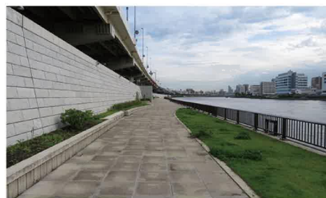
防潮堤(隅田川)
