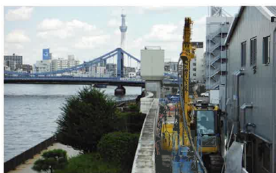
堤防の耐震対策の様子(隅田川)
