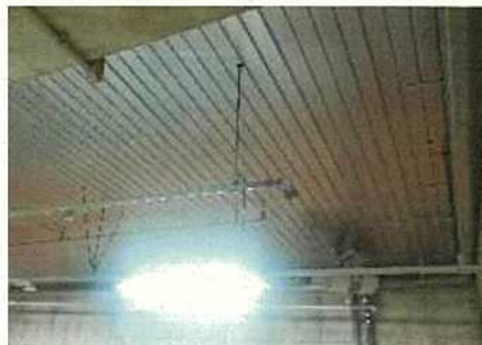
【中規模修繕による補修】
