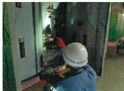
【応急的な補修の様子】
