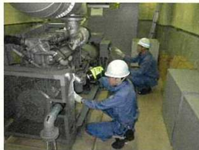
【設備点検の様子】
