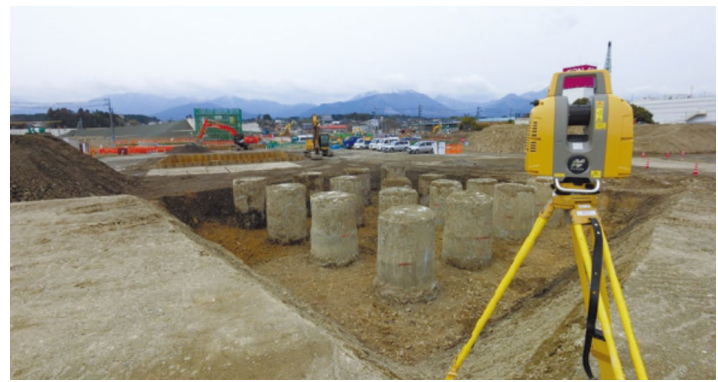
例：橋梁下部工事の出来形計測 画像出典：水谷建設
