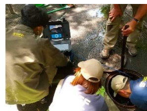
排水管内の樹根除去作業
