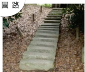
石段の据え直しによる安全性の確保と景観維持（浜）
