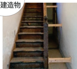
重要文化財を保全するための支柱による応急的補修（岩）
