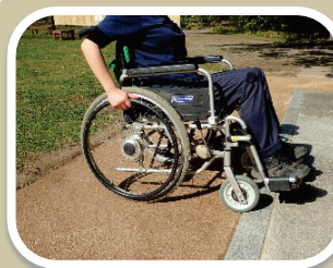
四阿と園路の間に土系舗装によるスロープ設置し、段差を解消。脱輪防止の縁石や手すりも取り付け (清)
