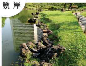
黒ボク石積護岸の応急的補修（芝）
