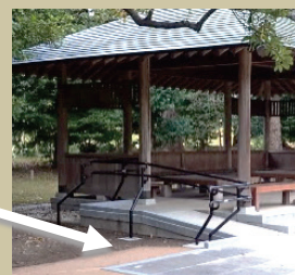
四阿と園路の間に土系舗装によるスロープ設置し、段差を解消。脱輪防止の縁石や手すりも取り付け (清)
